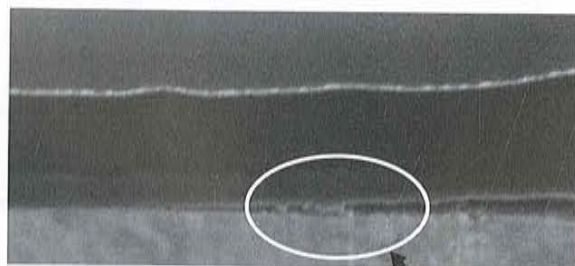
基材と中間層がはく離
